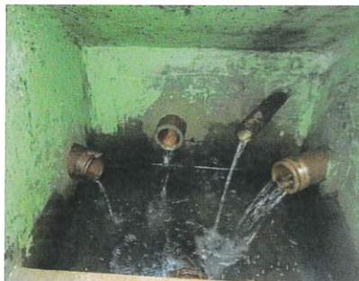
Untertägiges Bauwerk: Dort werden drei Grundwasserdrainagen und ein Zulauf aus einer anderen Quelle gesammelt.
